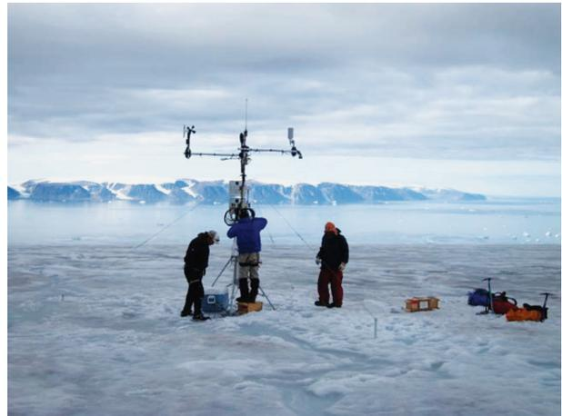
写真 3. カナック氷帽上 SIGMA-B (標高 944 m) における自動気象観測装置の設置作業 (2012 年 7 月 22 日)
